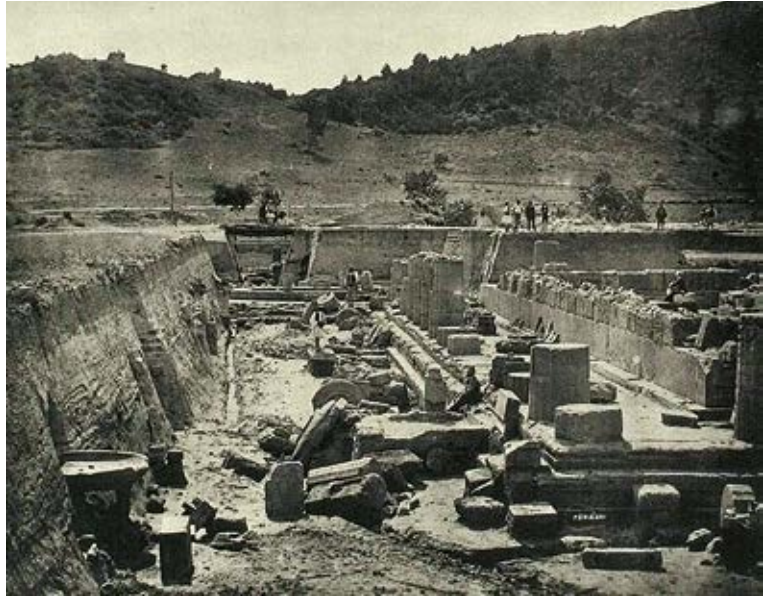
Fig. 1 ~ Trincea di scavo dell'Herion di Olympia, 1877-1878 (CURTIUS 1879, taf. I).
